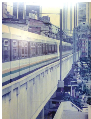
Gráfico 11. Viaducto. Biblioteca Metro. Bello. Archivo
