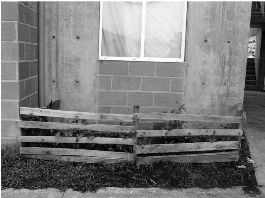
Figura 51. Privatización del espacio exterior.
