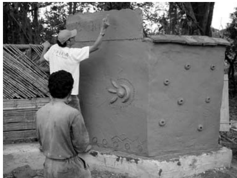
Figura 12: Práctica de bahareque. Construtierra, 2006. Monasterio de Santo Ecce Homo, Colombia.
