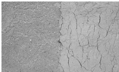
Figura 7: Comparación entre la retracción de un revestimiento de barro con paja y sin paja. Lo Vicuña, Chile.
