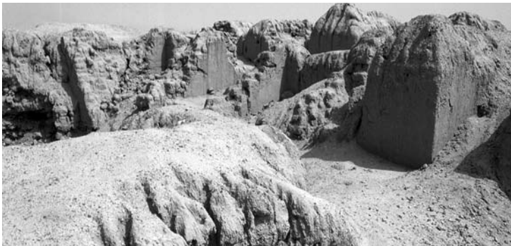
Figura 4: Desintegración paulatina de muros hechos con tierra arenosa. Chan Chan, Perú.
