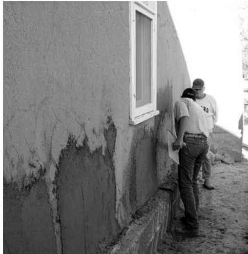
Figura 5: Pruebas comparativas de revestimientos de barro. San Ysidro, New Mexico.
