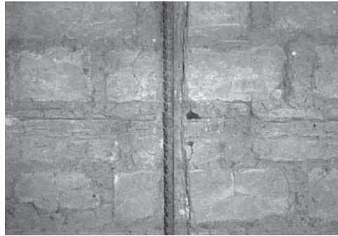
Figura 37: Instalación de las barras.
