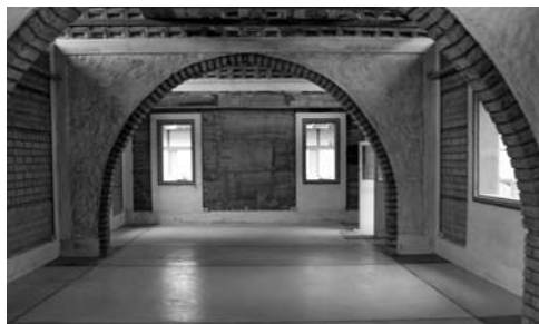
Figura 4: Vista interior del sector de aula-taller del CRIATIC-FAU UNT. Muros de mampostería de BTC y tapial, cubierta de bóvedas de cañón corrido con BTC livianos.
