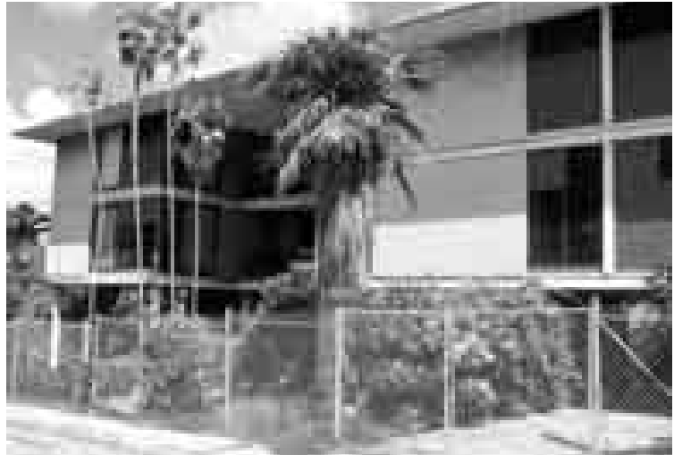
Figura 11: Fachada principal. Uso del alero como protección solar. Diseño por el Arquitecto Frank Martínez. Año 1955. Calle 47, No. 1220, entre 36 y 38.
