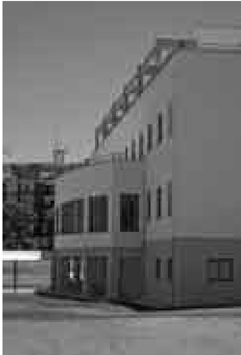
Figura 4: Antiguo Colegio de Huérfanos Ferroviarios. Detalle de la fachada este.
