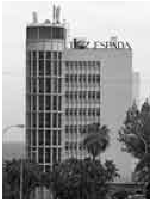
Figura 8: Hotel Pez Espada, Torremolinos, Málaga. Vista general de la fachada Oeste de acceso.
