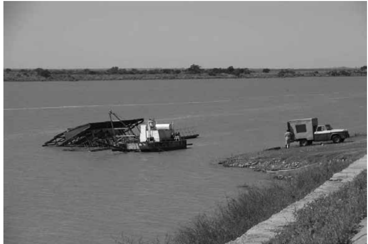
Figura 6: Muelle fotante de la localidad de Intelvecia. Estado actual.
