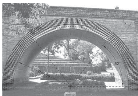
Figura 5: Alzada del arco No. 8 (sentido norte-sur) del puente del Humilladero sobre el río Molino, en Popayán (1868).
