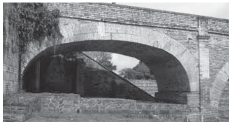
Figura 9: Arco carpanel en el puente del Humilladero sobre el río Molino, en Popayán (1868).
