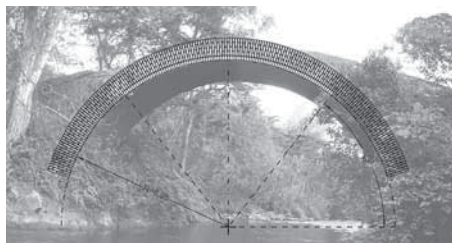
Figura 6: Puente sobre el río Ovejas, entre Popayán y Cali (1877). Fuente: Elaboración propia sobre fotografía del autor (2008).
