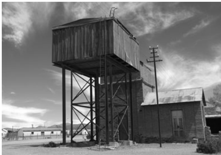
Figura 4: Tanque de agua prefabricado en perfiles de hierro, chapa y cobertura de madera para evitar el congelamiento. Situado en el Estación Tres Cruces sobre la línea Jujuy-La Quiaca.
