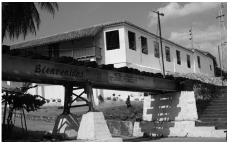
Figura 15: Paso elevado del Ferrocarril de La Dorada en zona urbana de Ambalema, Km 111.
