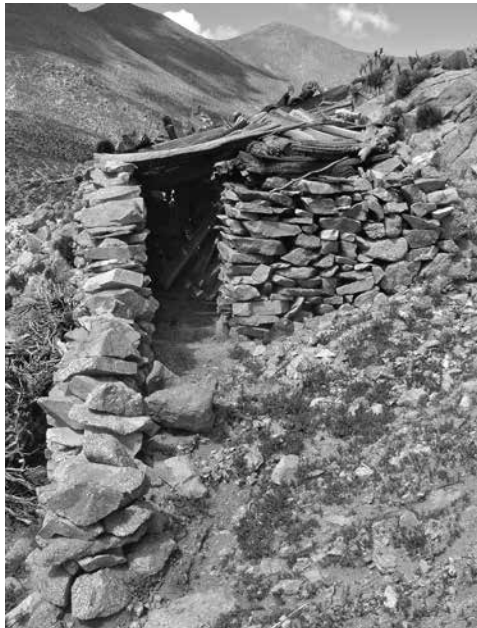
Figura 2: Recinto cubierto en una estancia construida aprovechando un alero de piedra y con un cerramiento en pirca seca. Fotografía: Jorge Tomasi
