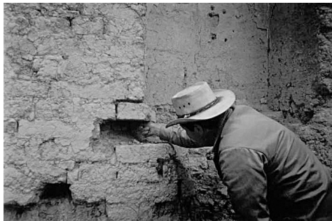
Figura 3: Capilla doctrinera de Tausa Vieja. Proceso de extracción de unidades de adobe. Fotografía: Juan Carlos Rivera
