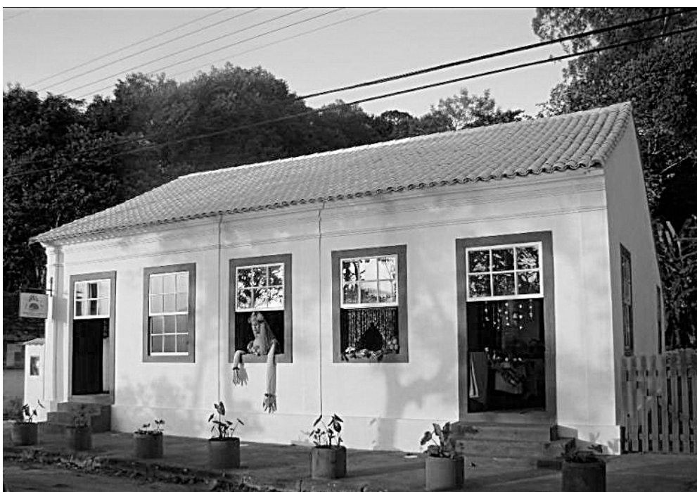
Figura 1: Casas remanescientes del período colonial portugués. Paredes externas autoportantes en piedra y paredes internas en 'pau a pique' (Aduana turística de Sambaqui, Isla de Santa Catarina, Brasil). Fuente: Associação do Bairro de Sambaqui (ABS).
