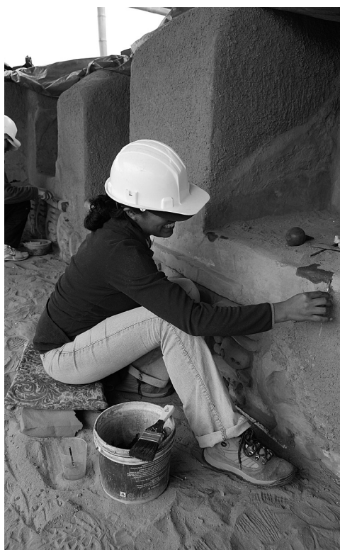
Figura 3: Restitución de revoques con barro en el Palacio Tschudi, Chan Chan, Perú. Fotografía: L. Guerrero.
