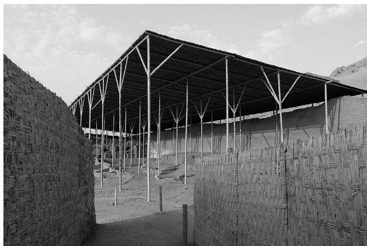
Figura 7: Uso de materiales tradicionales y barreras corta vientos en las Huacas de Moche, Perú.
