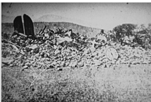
Figura 1: (Izquierda) Catedral de Cúcuta antes del sismo de 1875. (Derecha) Colapso estructural después del evento sísmico.
