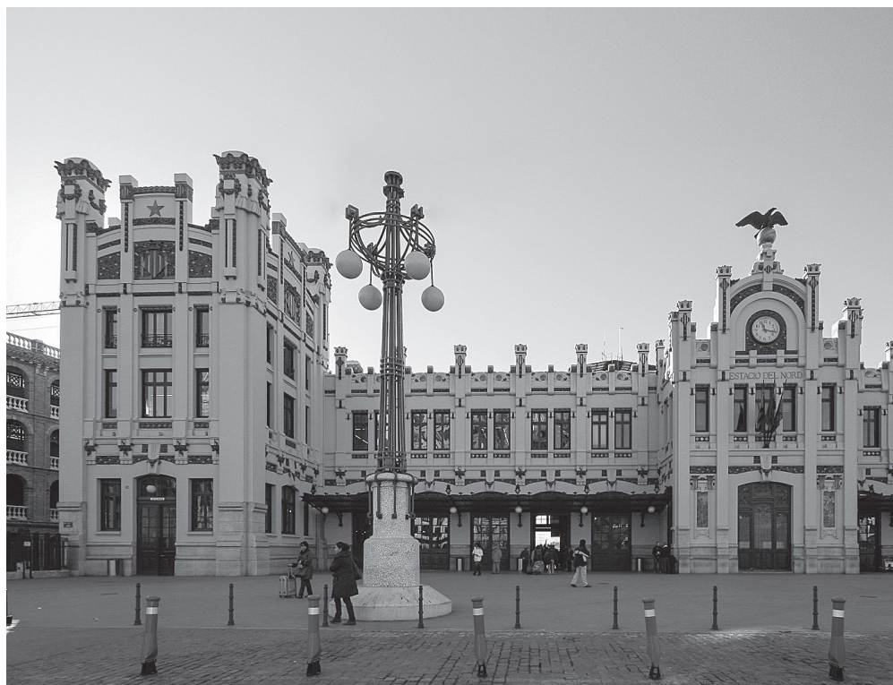
Figura 3: Estación de Valencia, Fachada recayente a andenes y vías Fuente: Aurora, 2011
