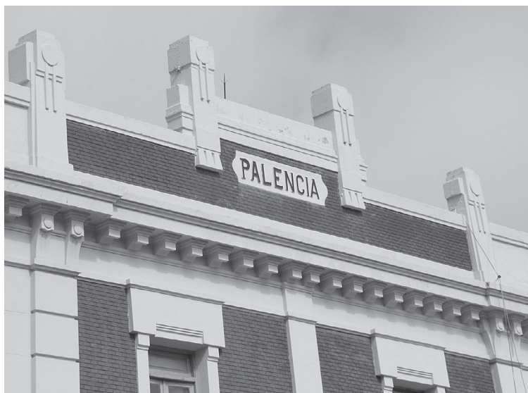
Figura 6: Estación de Palencia. Detalle de remate en la fachada con el característico ladrillo rojo
