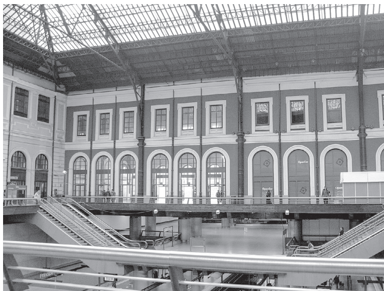
Figura 4: Estación Príncipe Pío, Madrid. Vaciado bajo el edificio de viajeros
