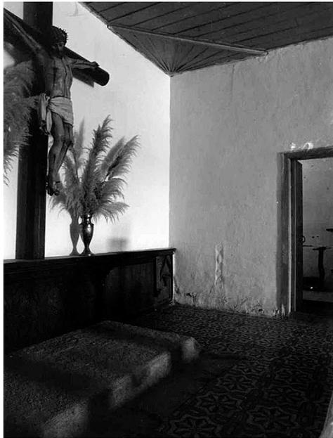
**17** Aunque el sistema constructivo de la cubierta parecía responder a una cierta "informalidad" en la disposición de los elementos, estas cubiertas estaban conformadas por cerchas estructurales (con todos sus componentes) y otra estructura de canes y cabios que conformaba el alero. Lo cierto es que se utilizaban toda clase de piezas (aserradas y sin aserrar) y maderas, y se disponían sin ninguna estética porque se suponía que el cielo raso ocultaría la estructura.
