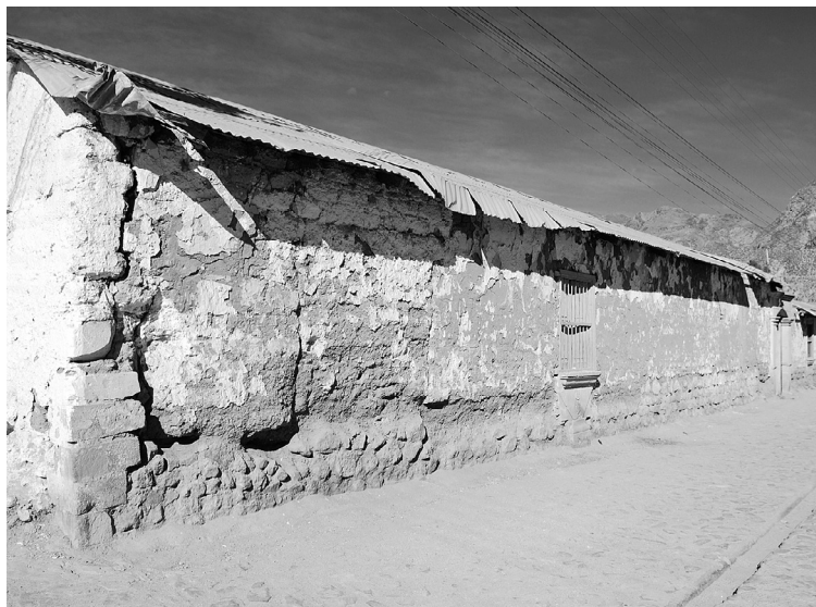
Figura 1: Vivienda en la localidad de Putre en la Región de Arica y Parinacota. Es evidente su nivel de deterioro que acrecentó el daño sísmico durante el terremoto de 2005
