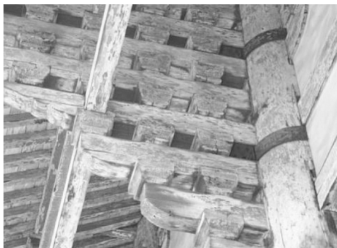
Figura 22: Templo Tōdai-ji en Nara. Detalle del refuerzo estructural en hierro del sistema estructural en madera denominado tokyō.
