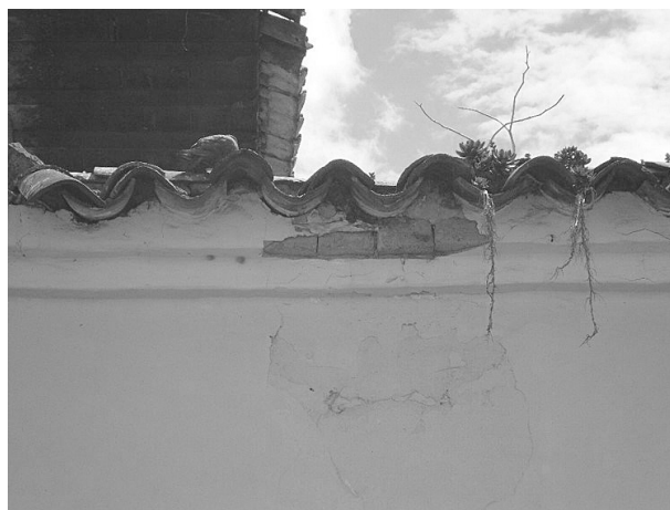
Figura 12: Patologías en muros de adobe de la Casa Cogua: a) Erosión del adobe, b) Presencia de microorganismos, c) Humedad y suciedad Fuente: elaboración propia
