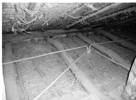
Figura 19: Cielo raso suspendido de las vigas de cubierta. Fuente: elaboración propia
