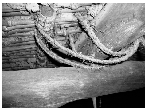
Figura 23: a) Distribución de los elementos de cubiertas, b) Uniones tipo caja en elementos de cubierta, c) Uniones con fibras vegetales en elementos de cubierta. Fuente: elaboración propia
