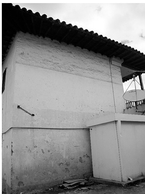
Figura 12: Patologías en muros de adobe de la Casa Cogua: a) Erosión del adobe, b) Presencia de microorganismos, c) Humedad y suciedad Fuente: elaboración propia
