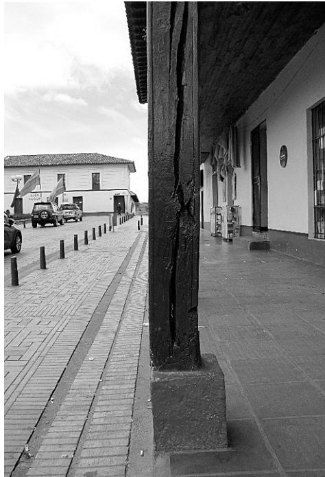
Figura 16: Patologías en los pilares de madera: a) Pérdida de sección por descomposición de la madera, b) Agrietamientos, desplazamiento y pérdida de verticalidad de los pilares en madera, c) Aplastamiento de los capiteles de las columnas Fuente: elaboración propia
