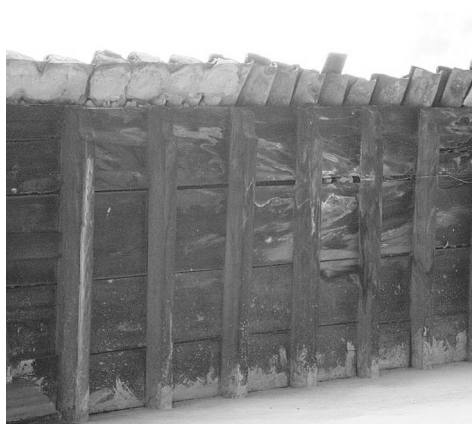
Figura 24: Descomposición de la madera en elementos de cubierta. Fuente: Archivo de los autores
