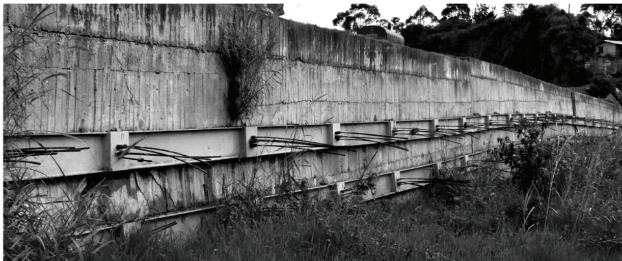
Figura 2: Muro de contención, vigas de refuerzo y tensores en el Km 6 (Marzo del 2012).
