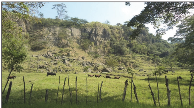
Figura 8. Escarpe que enmarca la zona de estudio, en el cual afloran intercalaciones de limolitas, areniscas y arcillolitas. Puede apreciarse el cono de derrubios asociado a dicho escarpe, producto de un fenómeno de caída de rocas. Fuente: Montoya-Cañola, S.; Álvarez-Gutiérrez, Y.
