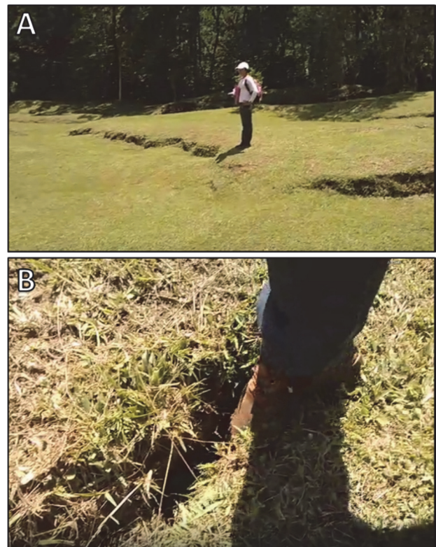
Figura 9. Grietas observadas en el sector SW de la zona de estudio (Parcelación llanadas). A) Grieta de rumbo. B) Grieta de tracción. Fuente: Montoya-Cañola, S.; Álvarez-Gutiérrez, Y.
