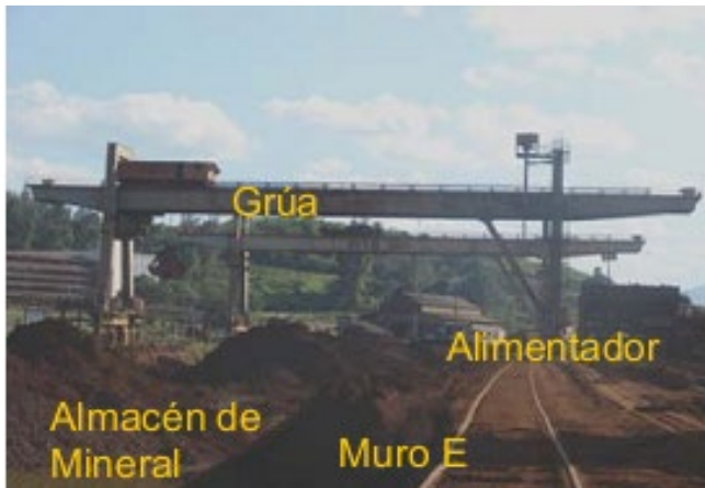
Figura 4. Vista frontal del depósito. Fuente: Los autores.
