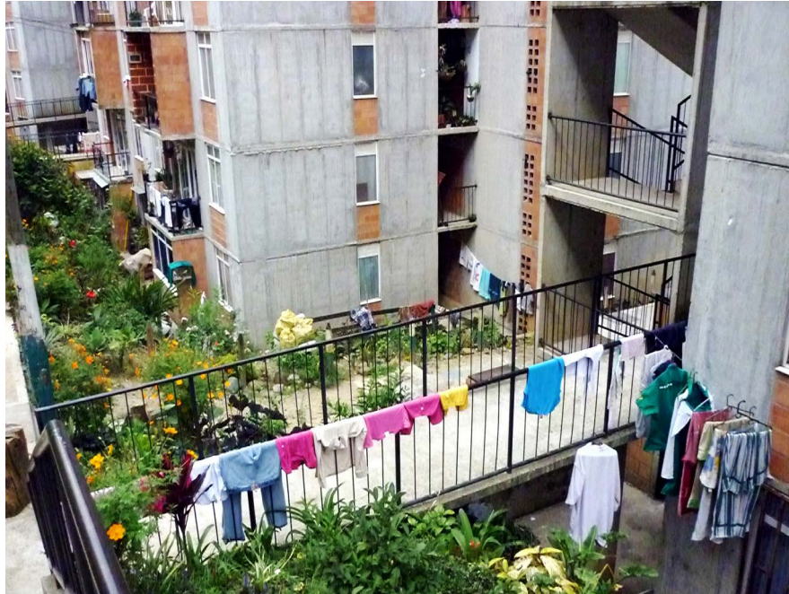
Imagen 2. Adecuaciones del hábitat
