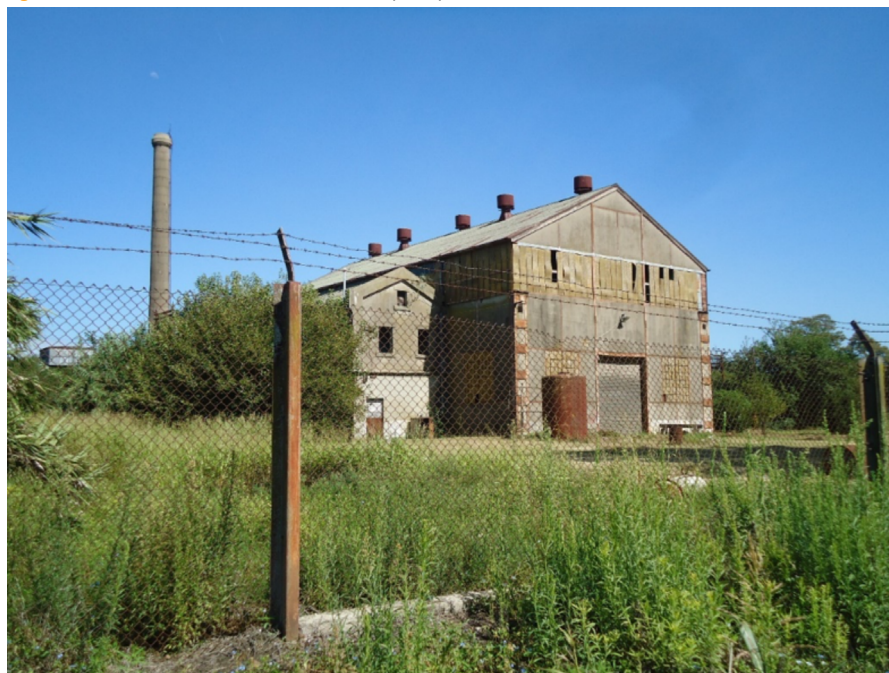
Figura 8. Vista externa de ex-usina eléctrica. En la parte posterior se observa la torre de enfriamiento
