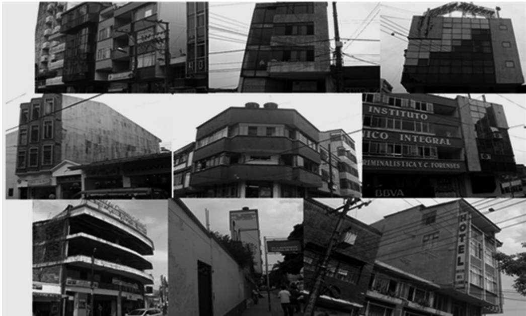
FIGURA 9. Fotografías que muestran algunos ejemplos de las malas condiciones estructurales y de sismo resistencia en algunos de los edificios del centro de la ciudad, como la colindancia entre los edificios de la fotografía de la esquina superior izquierda. Igualmente se observan aquí casos como la falta de reforzamiento estructural, fachadas en voladizo y geometría irregular con escalonamientos o retrocesos. Con estos ejemplos es claro que la vulnerabilidad frente a un sismo se incrementa de manera dramática para Villavicencio.
