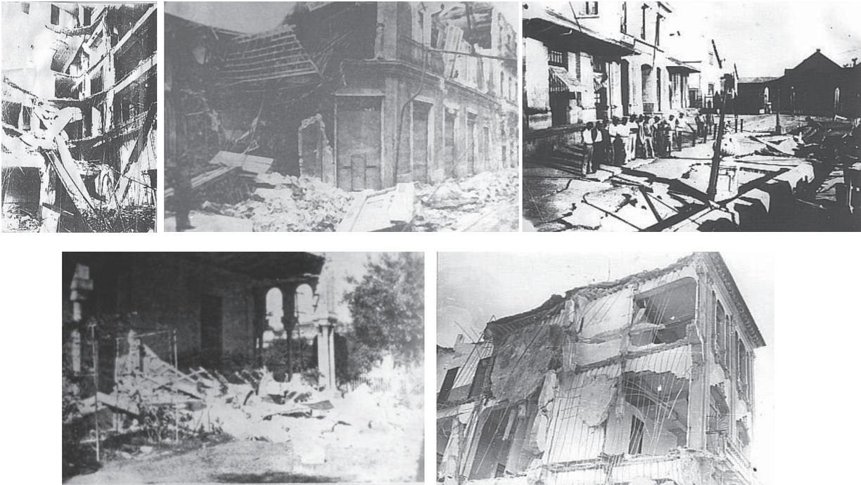
FIGURA 7. El terremoto de 1932.02.03. Imágenes de daños causados en Santiago de Cuba. La intensidad macrosísmica es asignada con valor de VIII MSK (Chuy, 1999). Fotos cortesía del Centro Nacional de Investigaciones Sismológicas, CENAIIS, Cuba.
