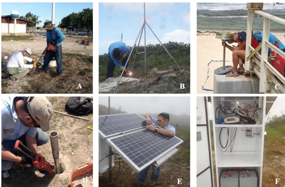
**Figura 4.** A. Perforación inclinada del hoyo SO en la estación CN43. B. Fijación con soldadura de las partes del SDBM de la estación CN44. C. Fijación de la antena Choke Ring de la estación CN49. D. Aplicación del pegamento tipo epoxi de dos componentes para fijar el poste de la unidad de alimentación y comunicación. E. Montaje de las celdas solares. F. Vista del interior del gabinete que contiene el receptor NetR9, el banco de baterías y conexiones restantes.
