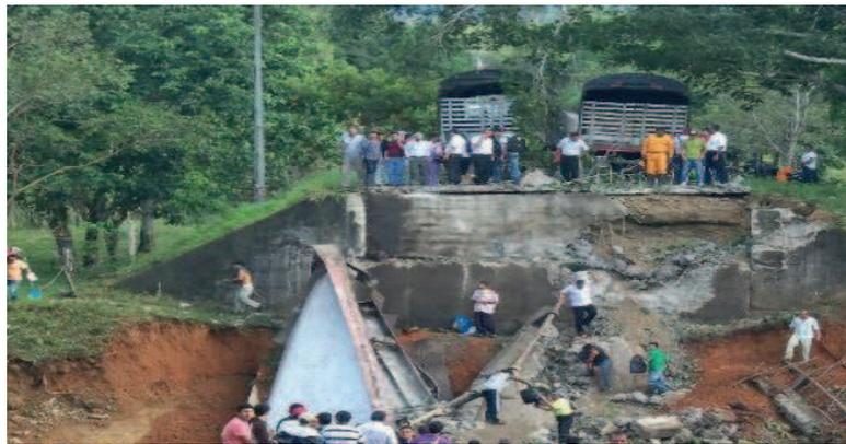
**Figura 11.** Panorámica del estribo sur del puente Riecito luego del colapso.
