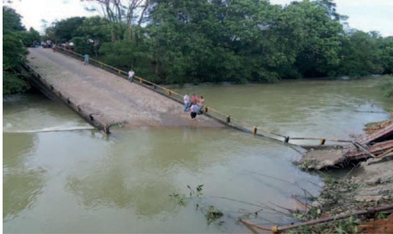
**Figura 10.** Panorámica lateral del puente Riecito luego del colapso.
