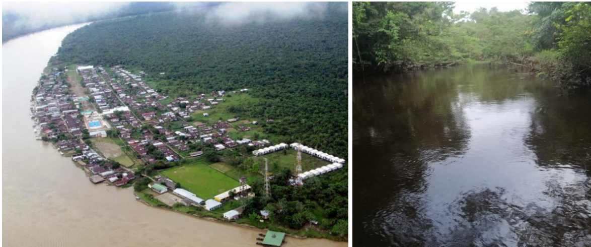
Figura 1. Panorámica de la cabecera municipal de Vigía del Fuerte ubicada en las coordenadas 06°35'20"N 76°53'42"W (izquierda), y del punto de captación en el afluente Ñagaradó, ubicado en las coordenadas 6°36'34.8192"N 76°51'22.5821"W (derecha)
