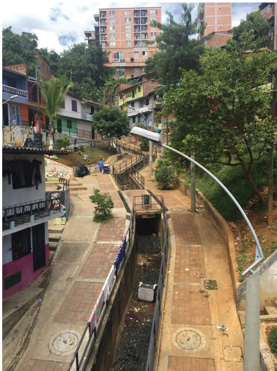
Figura 3. Estado actual de la quebrada Juan Bobo
