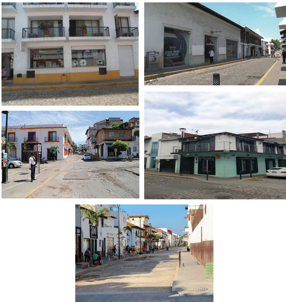
Figura 5. Imágenes de la calle Morelos
