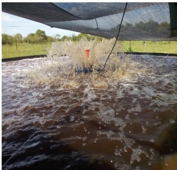
**Figura 5.** Funcionamiento del sistema de aireación Splash.
