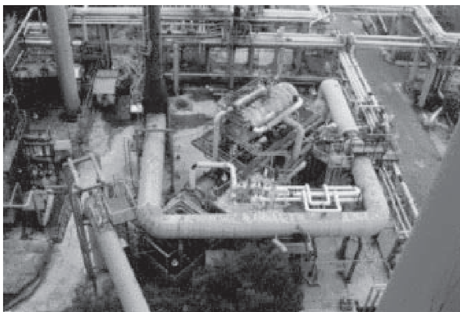
Figura 1. Fotografía panorámica, vista desde el regenerador, del Enfriador de Gases Combustibles, EGC, de las líneas de transferencia y de la chimenea
