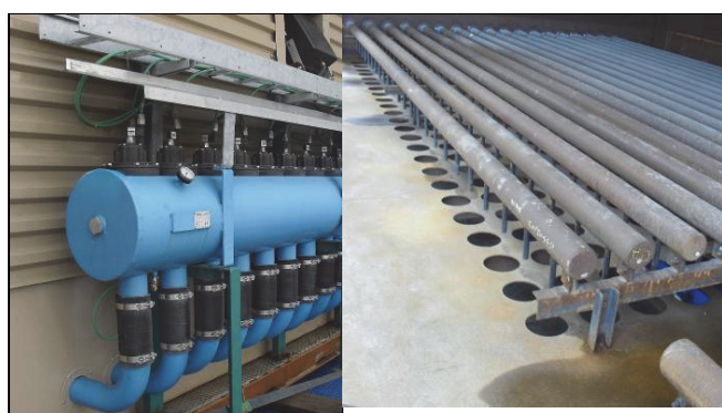
Figura 5. a) Detalle de un tanque de aire con 18 válvulas de diafragma b) Detalle de las tuberías de soplado (24 mangas/tubería) con las boquillas de inyección del aire. Fuente: Fotos propias.
