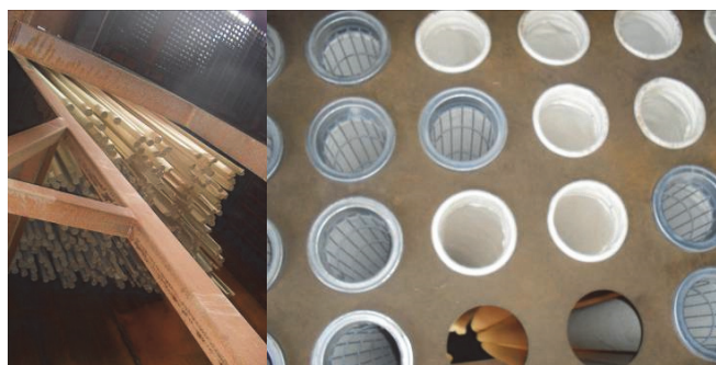
Figura 4. Instalación de las mangas. a) Vista interna del compartimento b) Detalle del sistema snap-ring y de la jaula portamangas, visto desde la parte superior “walk in plenum”. Fuente: Fotos propias.
