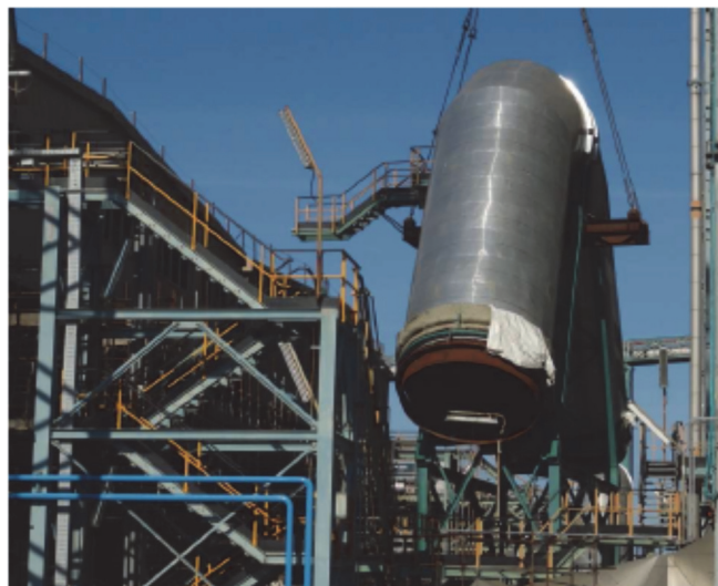
Figure 3. Instalación del conducto de equilibrio del ingreso. Fuente: Fotos propias.
