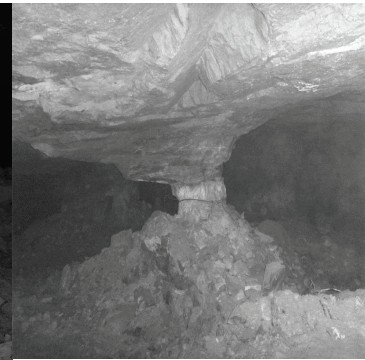
Figura 9. Pilar mostrando falla por control estructural, grietas axiales por esfuerzo cortante, desplazamiento de bloques, eyección y meteorización. Batolito de Segovia, Antioquia.
