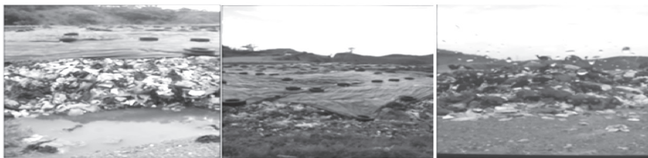
Figura 1. Vertimiento de residuos sólidos a cielo abierto en la zona de La Dorada (Caldas)
