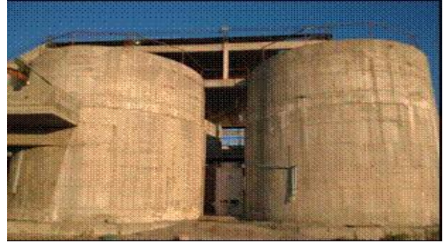
Fig.1. Fermentador MTPR (Concrete). Expuesto a intemperie.
