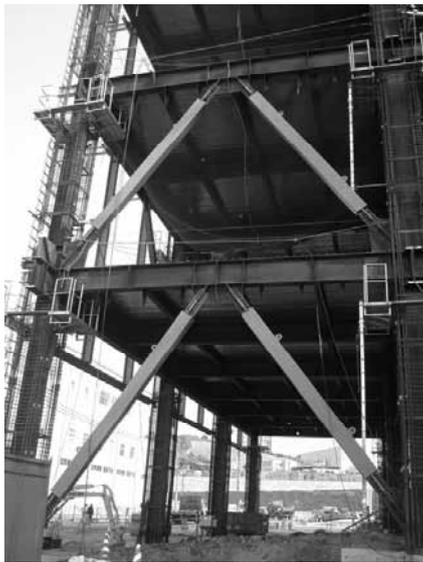
**Figura 3.** Edificio de acero con riostras de pandeo restringido. Foto cortesía del profesor Mamoru Iwata, Universidad de Kanagawa, Japón
