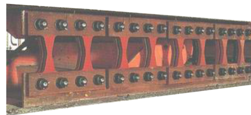
Figura 10. Disipadores histeréticos metálicos. a) Tipo TADAS. b) Tipo panel
