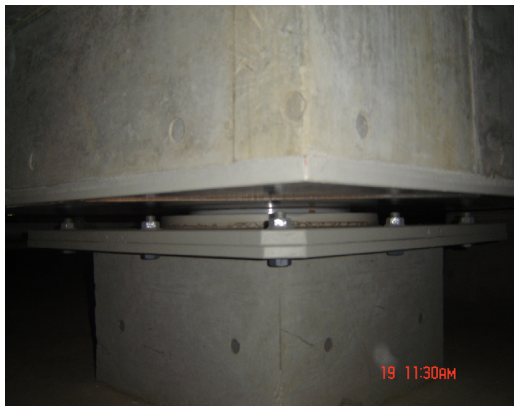
Figura 4. Aislador de caucho natural
