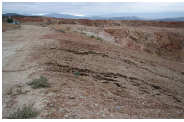
Figure 1. Surcos de erosión en una ladera de pendiente moderada antes de restaurar
