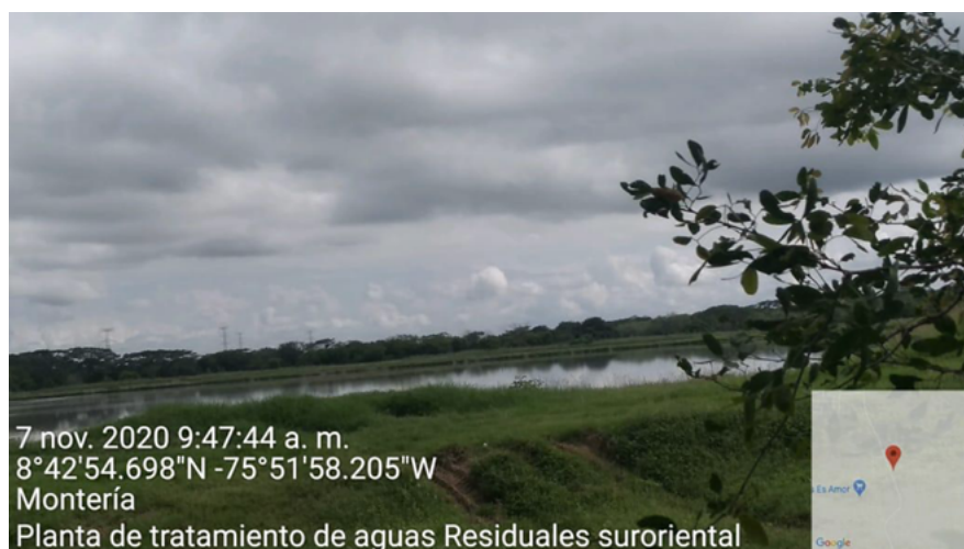
Figura 10. Poda de taludes laguna de oxidación suroriental
