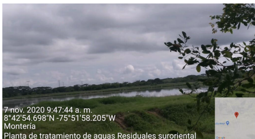
Figura 2. Planta de tratamiento de agua residual Suroriental
