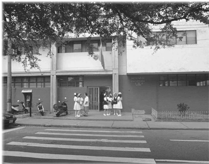
Fachada antigua Facultad de Enfermería
