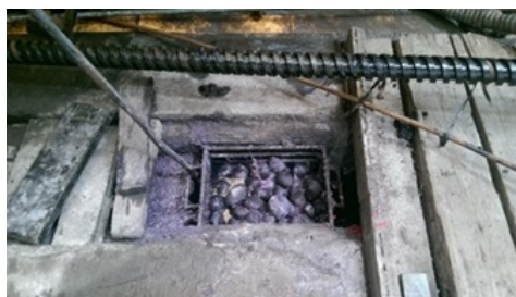
Figura 1: Punto de recolección de la muestra de agua residual de curtiembre. Se observa una caja rejilla con sustrato filtrante (rocas) con el fin de retirar pelos y carne procedente del proceso de pelambre. El flujo del agua es de izquierda a derecha y la muestra fue recolectada en la salida de la caja.
