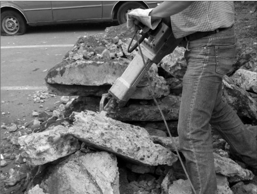
**Figura 1.** Demolición con martillo neumático
