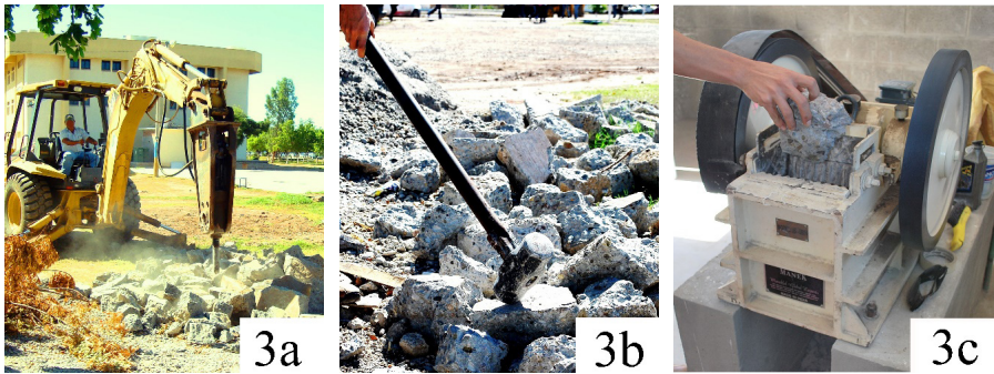
Figura 3. Proceso de trituración del hormigón de pavimento.
