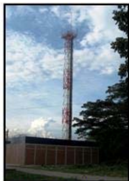
Figura 2. Estación base ubicada al nivel del suelo.
