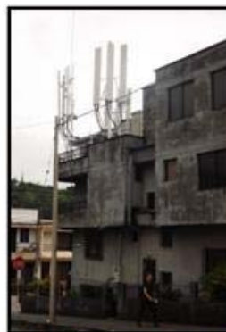
Figura 4. Estación base localizada en la azotea de una vivienda.
