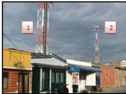
Figura 7. Estaciones base ubicadas a menos de 300 m una de la otra.
