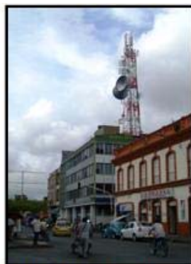
Figura 3. Estación base localizada en la azotea de un edificio.
