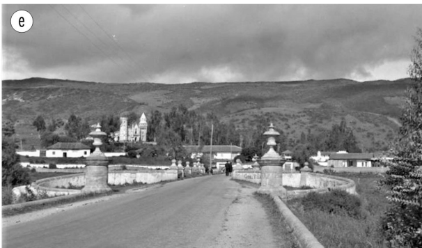
e. Fotografía del Puente del Común y del poblado La Caro a comienzos del siglo XX; cruce entre vías y el ferrocarril que incidió en la transformación del paisaje circundante. Fuente: G. Cuellar, 1930. Banco de La República; https://babel.banrepcultural.org/digital/coleccion/pl7054coll19/id/223/rec/7
