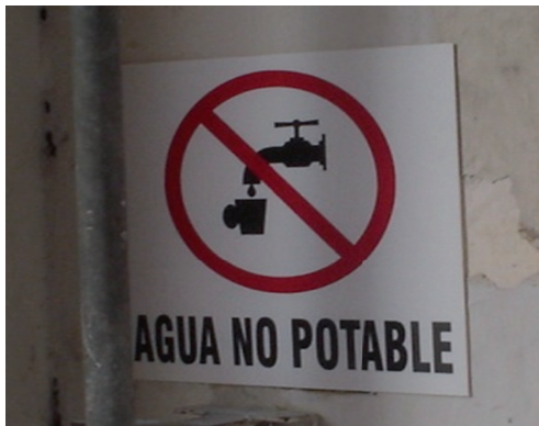
Foto 6. Señalización de agua no potable
