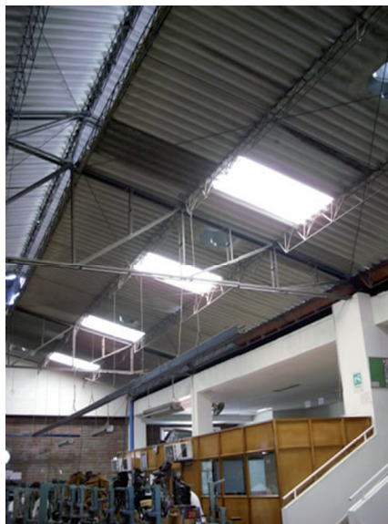
Foto 1. Implementación de tejas translúcidas para el aprovechamiento de luz natural
