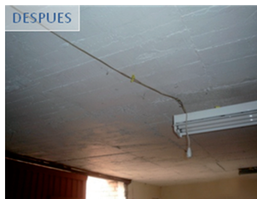
Foto3. Cableado después de mantenimiento
